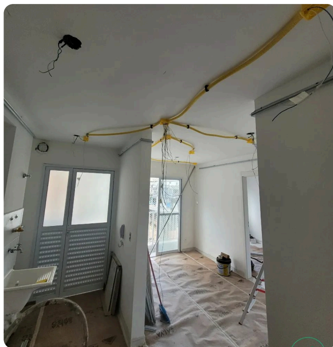
Registro de obra. Infra elétrica distribuída acima do forro, antes do fechamento. Esse tipo de foto vai no relatório: o que fica escondido, documentado.
